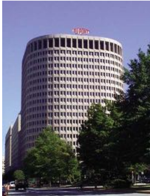
The Brandywine Building in Wilmington, Delaware. สำนักงานใหญ่ของดูปองท์ ในเมืองวิลมิงตัน รัฐเดลาแวร์ ในปัจจุบัน
